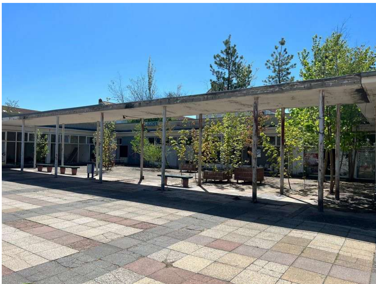
Slika 27. Očišćeno unutrašnje dvorište pre same intervencije
