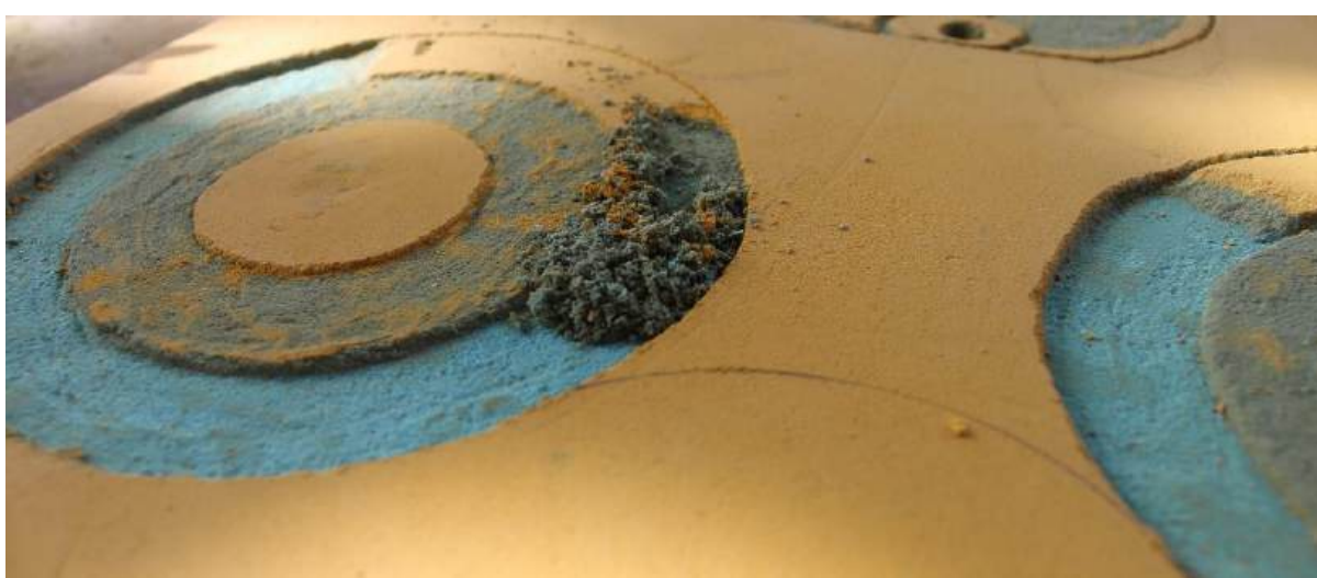
Слика 69 и 70. Груды у блатном малтеру (зграфито техника)
