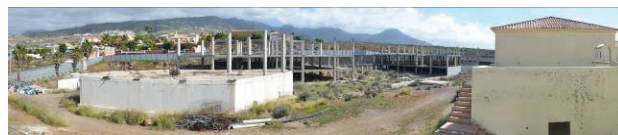
Slika 3. Postojeće stanje skeletne konstrukcije
