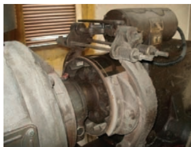
Slika 7. Prikaz kočnice lifta
