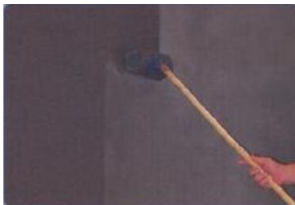
Slika 5. Nanošenje polimer modifikovanog cementnog premaza
