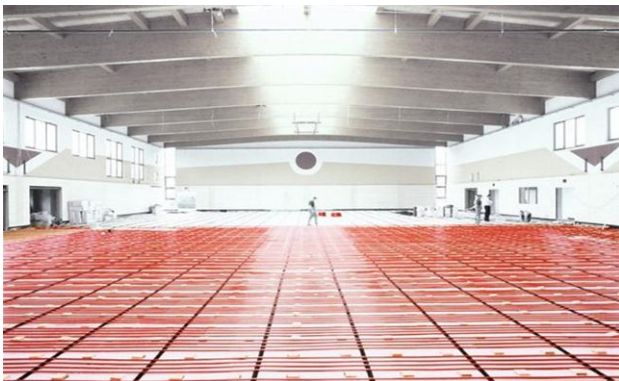
Slika 2. Postavljanje cevi za površinsko grejanje/hlađenje u jednoj industrijskoj hali
