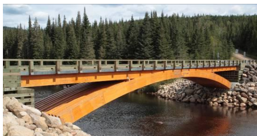
Slika 9. Drveni most „Montmorency South Forest Bridge“ (Kvebek, Kanada)
