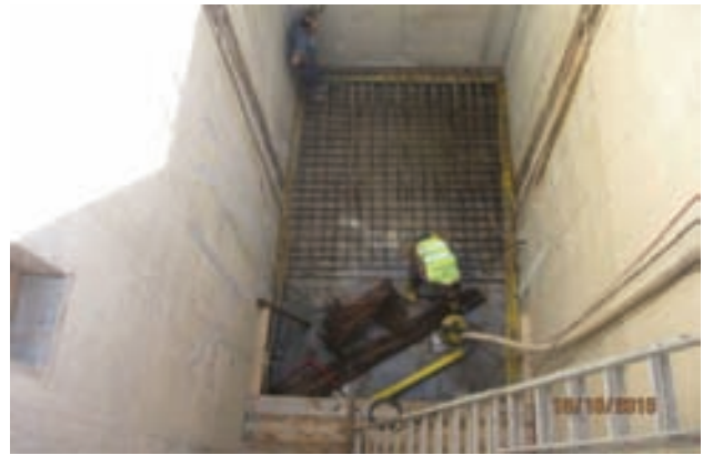
Slika 7. Postavljanje armatura donje ploče
