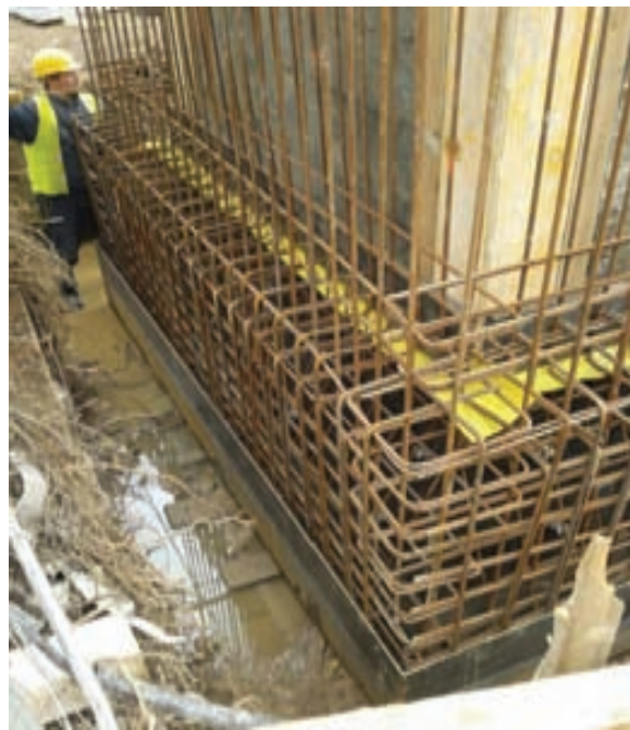
Slika 4. Armatura noža pumpne stanice
