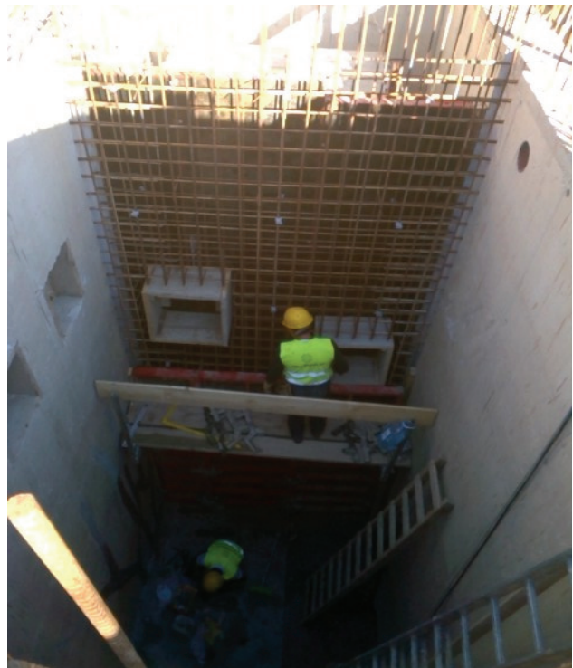
Slika 8. Izrada armature srednjeg zida pumpne stanice
