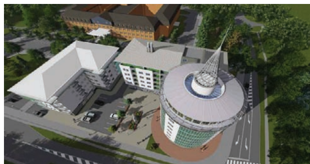
Slika 1. „MOST 1“ (levo) i „MOST 2“ (desno)
