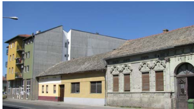
Slika 1. Postojeće stanje, Kisačka ulica
