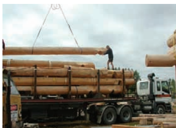
Slika 10. Transport i montaža
