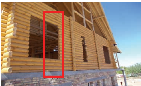
Slika 5. Izgled bočnog ukrućenja zida
