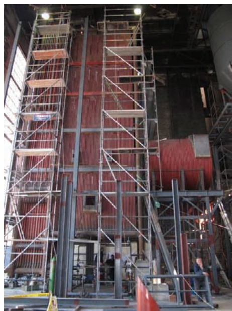
Slika 7. Vrelovodni kotao 18 MW sa ciklonom u TE-TO Sremska Mitrovica (u izgradnji)
