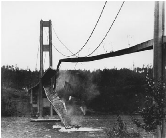
Slika 4 – Rušenje mosta Tahoma Narrows
