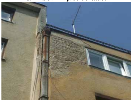
Слика 6. – Трошан малтер
