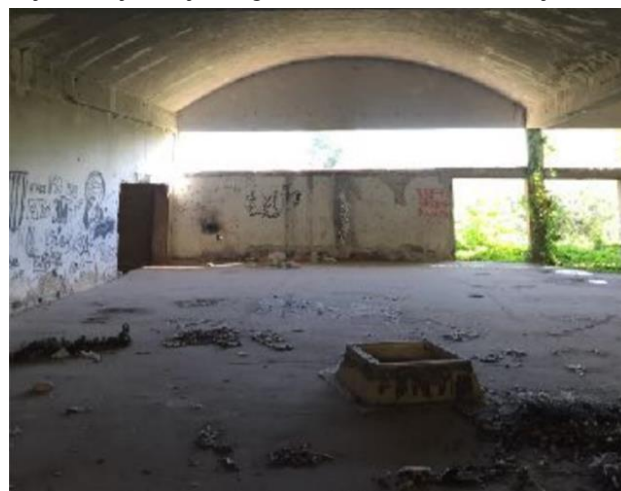
Ilustracija 1: Zatečeno stanje objekta na lokaciji
