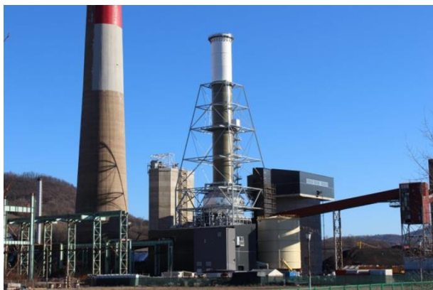
Slika 2. Postrojenje za ODG u izgradnji [1]
