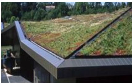
Slika 1. Primer ekstenzivnog krovnog vrta pod nagibom
