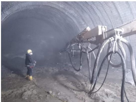
Slika 5. Nanošenje torkret betona
