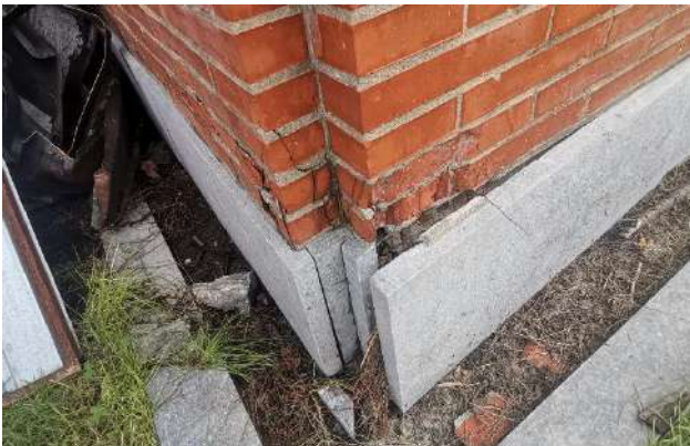
Slika 5. Odvajanje sokle
