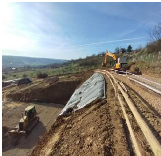
Slika 3. Izrada radnog platoa
