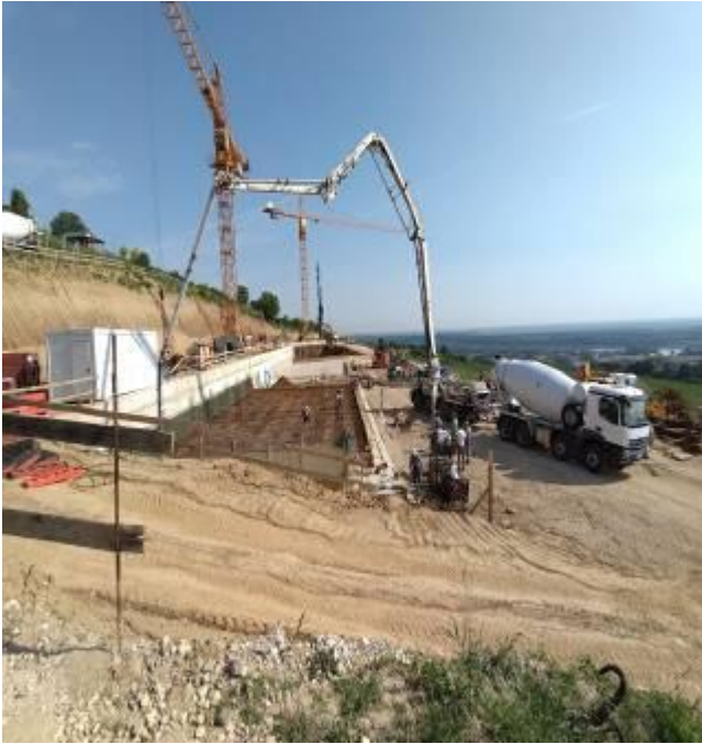
Slika 5. Izrada temeljne konstrukcije
