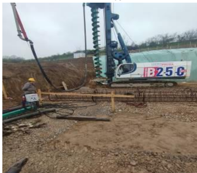
Slika 4. Bušenje šipova
