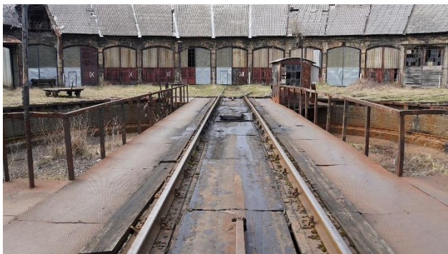
Slika 1. Objekat Ložionice sa okretnicom
