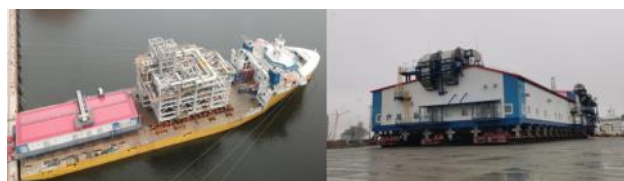
СЛИКА 4 – Central control building/electrical substation
