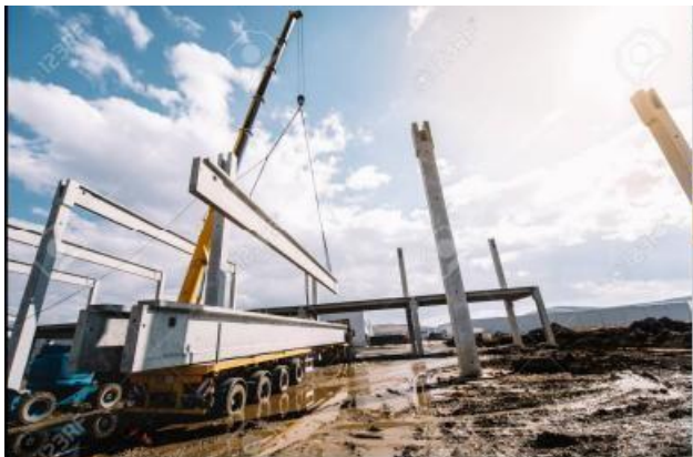
Сл. 6.1. Монтажа бетонског елемента [4]
