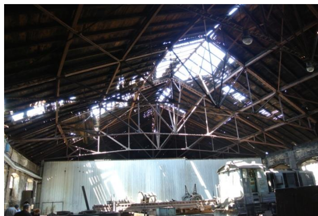
Slika 3. Unutrašnji prostor objekta ložionice [3]
