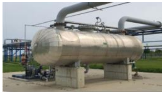
Slika 7. Posuda D-503 (horizontalni separator gas-tečnosti)
