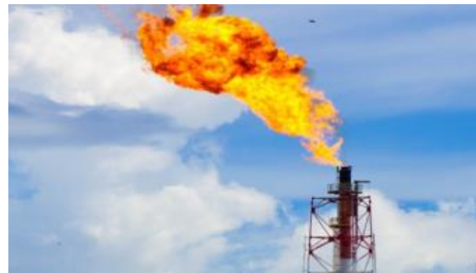
Slika 4. Ispuštanje viška gasova na visokoj baklji
