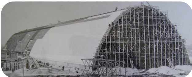
Prilog 1: Industrijski kompleks „Agrohema“ u završnoj fazi izgradnje, 1964. godina
