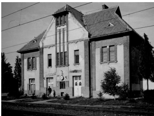
Slika 1. Izgled železničke stanice iz arhive [3]
