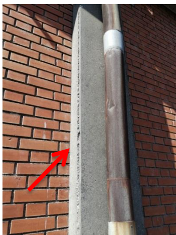
Slika 3 – Geometrijska imperfekcija AB stuba
