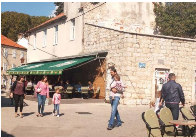
Slika 2. Odabrani objekat za rekonstrukciju [5]
