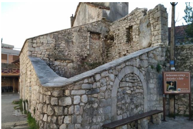
Slika 3. Odabrani objekat za rekonstrukciju [6]
