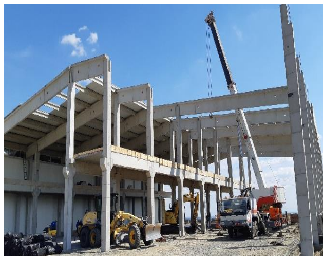
Slika 3. Ugradnja AB elemenata
