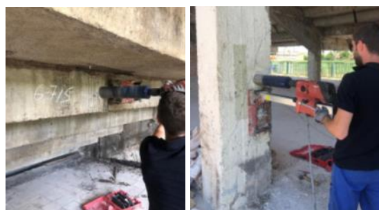
Слика 11 – Вађење бетонских језгара
