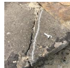
Слика 9 – Карактеристичне угаоне пукотине на крајевима талпе са или без трагова процуривања
