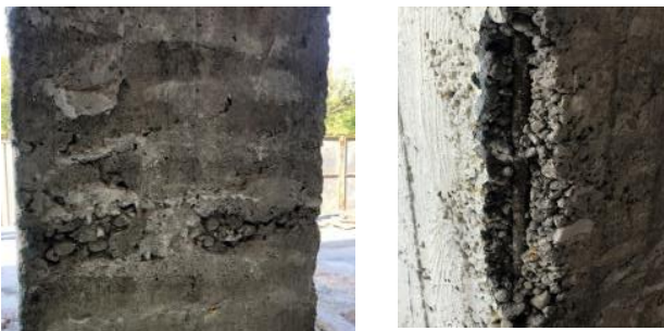
Слика 5 – Бетонско гнездо у доњем делу стуба (лево); саћаст, порозан бетон без малтерске компоненте, неговарајућег гранулометријског састава (десно)
