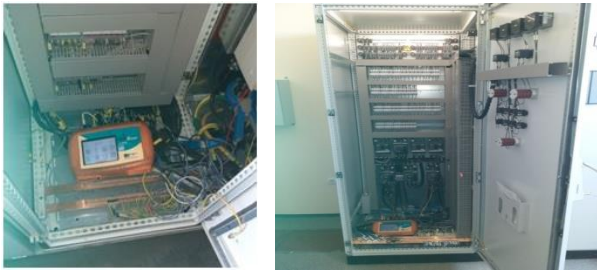
Sl. 3. Postavka mrežnog analizatora – MM1 (levo) i MM2
