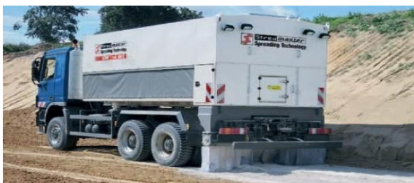
Slika 2: Nanošenje cementa pomoću cisterne
