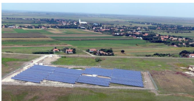
Slika 2. Fotonaponska elektrana Sajan
