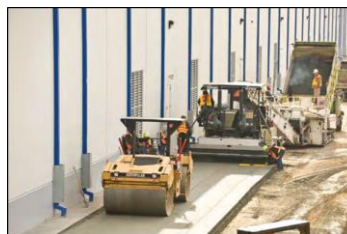
Слика 1. Уградња уваљаног бетона финишером и ваљком [2]
