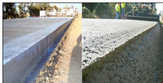
Слика 2. Изведени колник од класичног бетона (лево) и уваљаног бетона (десно) [3]
