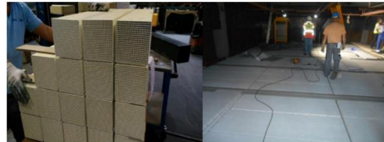
Slika 4 Katalizatorski elementi pre i nakon ugradnje [9]
