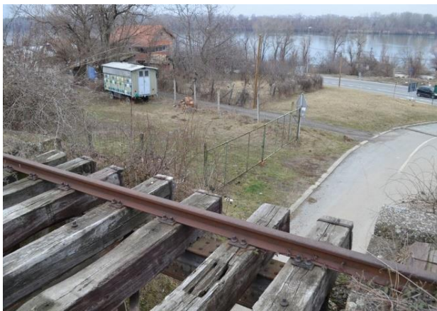
Slika 1. Deonica pruge sa pogledom na Dunav
