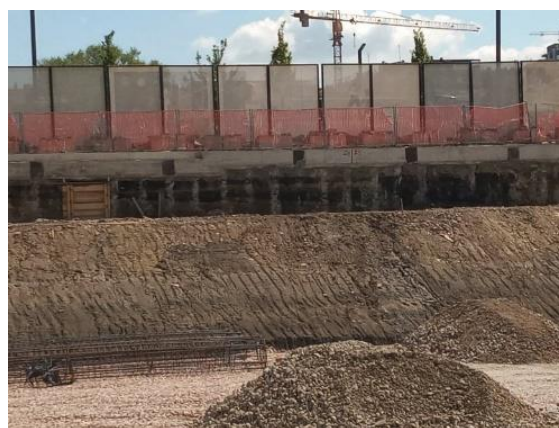
Slika 2.4. Izgled šipova sa yet groutingom
