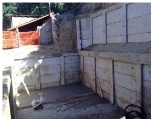
Slika 2.1. Izgled potporne konstrukcije Graditelj NS
