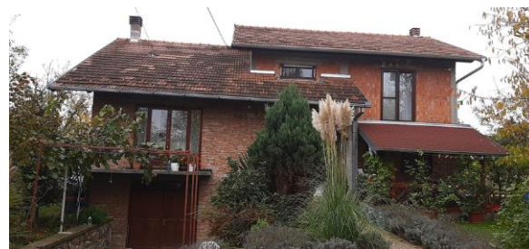
Slika 2. Izgled zapadne fasade objekta
