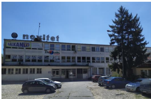
Slika 2. Izgled glavne fasade objekta
