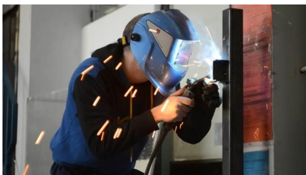
Slika 5.3 Zavarivanje konzolnih ispusta od IPE 80 profila
