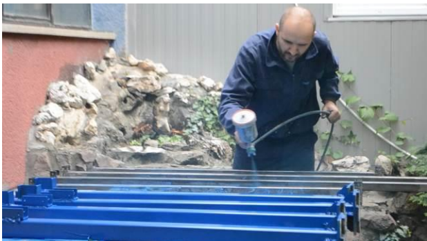
Slika 5.7 Završno farbanje elemenata konstrukcije
