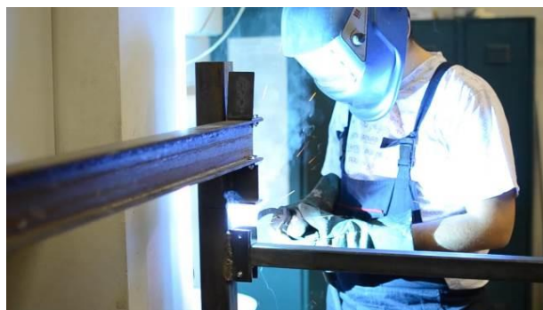
Slika 5.5 Zavarivanje uški poprečnih ukrućenja
