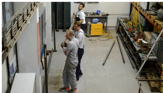
Slika 5.4 Probna montaža glavnog nosača šinske staze
