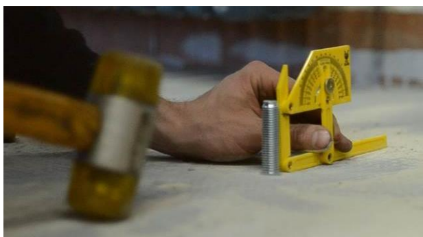
Slika 5.2 Postavljanje i podešavanje ankernih vijaka
