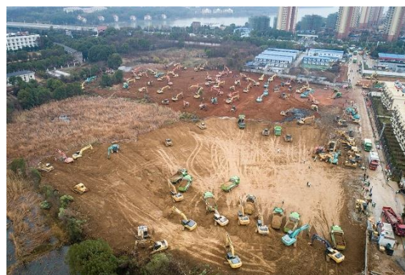
Slika 2. Izgradnja privremene ambulante u Vuhanu
