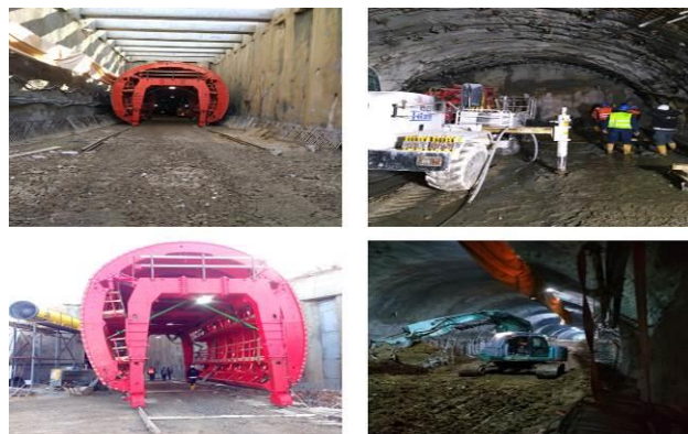
Slika 3. Tunel „Čortanovci“ u toku izgradnje
