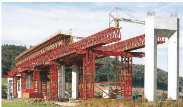
Slika 2. Lansirna skela ispod rasponske konstrukcije
