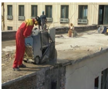
Slika 6. Sečenje tavanice brusilicom za beton
