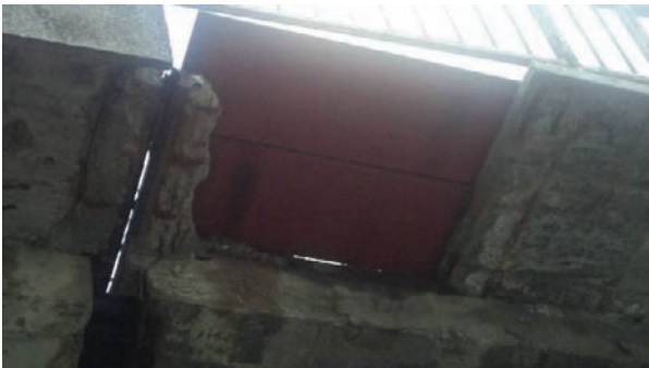
Slika 4. Oštećenja na pločama pješačkih staza
