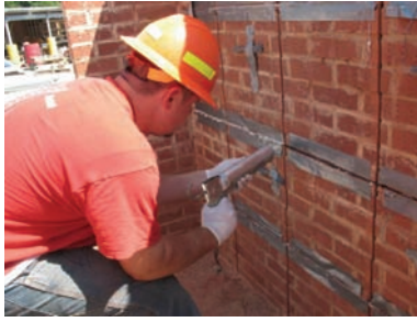
Slika 2. - Zasecanje zida, ugrađivanje FRP šipki i popunjavanje epoksidom
