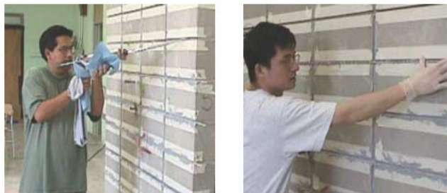
Slika 1. - Umetanje paste i ugradnja šipki
