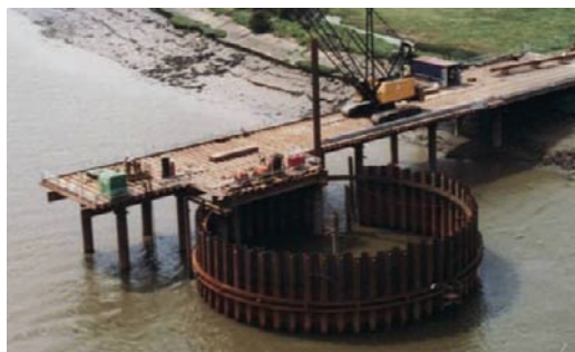
Slika 1. Postavljanje talpi za temelj mosta
