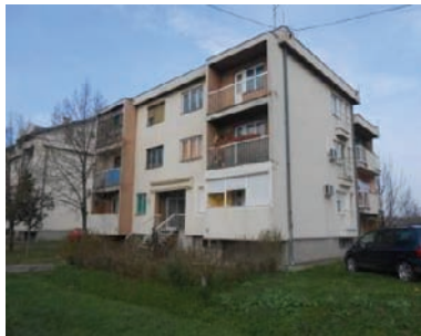
Slika 3. Spoljašnji izgled zgrade (južna fasada)
