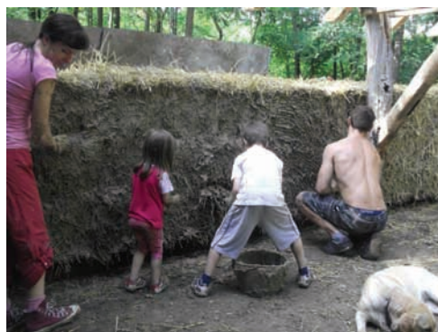
Slika 3. Sa unutrašnje i spoljne strane zidovi od slame se oblažu troslojnom mešavinom blata ( http://www.subotica.com )
