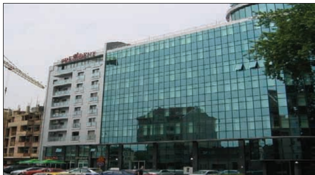
Slika 5. Poslovno – stambeni objekat u ul. Braće Ribnikar
