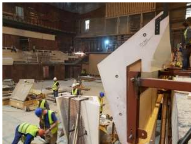
Slika 6 - prikaz vidljivih pločastih isečaka u okviru jednog elementa (levo) i montiran element sa bočnim rupama za pozicioniranje (desno)
