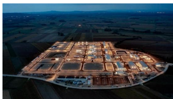
Slika 2.2 Kompresorska stanica – Velika Plana
