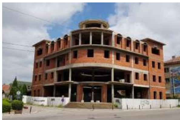
Slika 5. Postojeće stanje objekta
