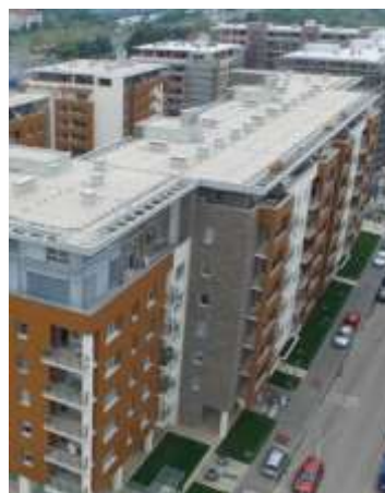
Slika 1. Ravan krov na zgradama
