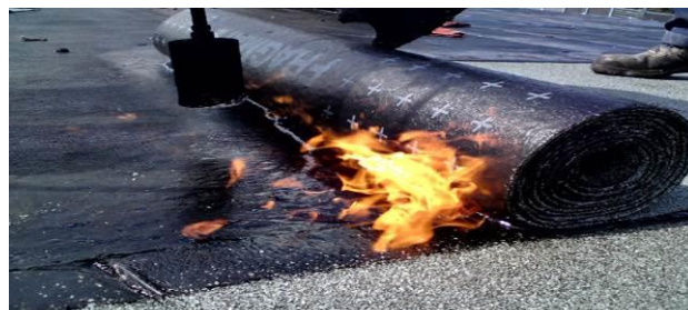
Slika 3. Postavljanje trake Kondora P-4
