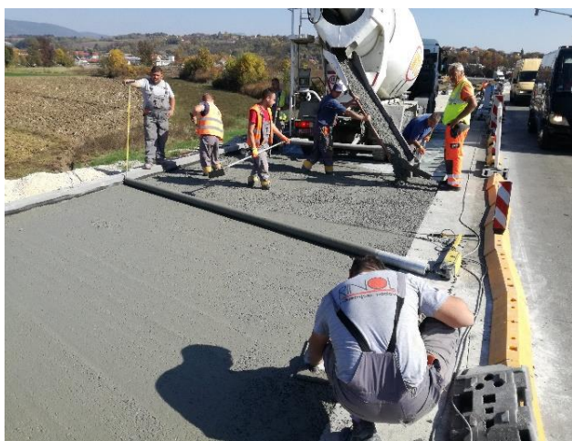
Slika 2. – Kompaktiranje vibro valjkom
