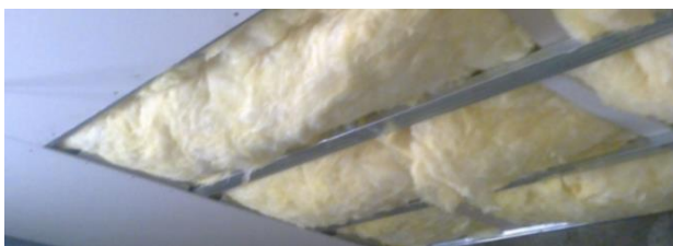
Slika 9. Spušteni plafon: Postavljanje staklene vune i gipskarton ploča na potkonstrukciju
